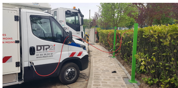
Station d'avitaillement GNV au siège de DTP2i.
