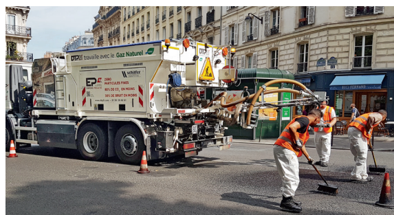
Réparation de chaussée avec l'EP+, une technologie unique, économique et respectueuse de l'environnement. Contrat avec la Ville de Paris.
