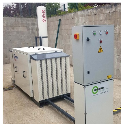
L'équipement de distribution de GNV et ses bornes de recharge sur le site de Marines.
