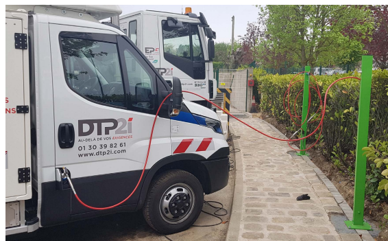
L'équipement de distribution de GNV et ses bornes de recharge sur le site de Marines.
