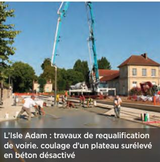
L'Isle Adam : travaux de requalification de voirie. coulage d'un plateau surélevé en béton désactivé
